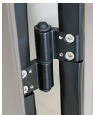
Gonds réglables vantaux repliables + joint anti-pince doigts
